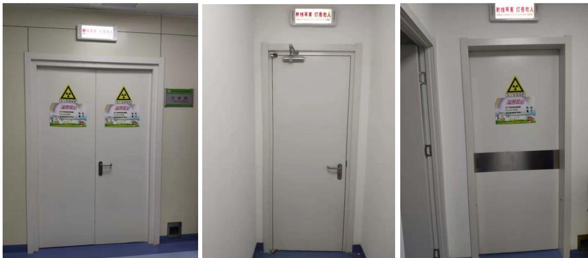
图 4-1 机房外工作状态指示灯及警示标识
